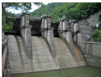
下流側から見た砥山ダム
