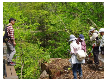
一の沢橋梁から崖下を見る
