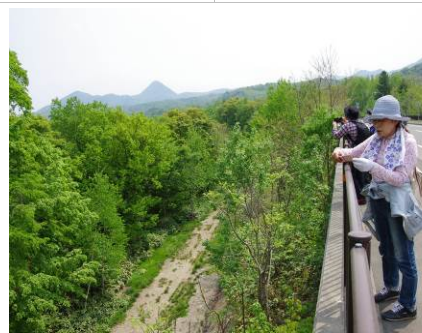
工事用道路?になった線路跡
