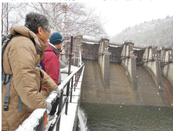
砥山ダム下流部分の調査
