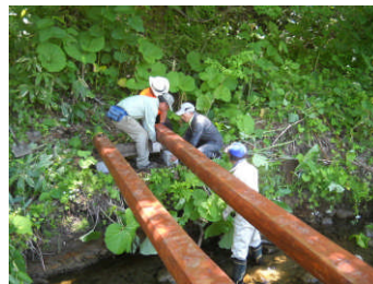
主桁用の丸太を調整
