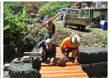
歩く部分の板を打ち付け
